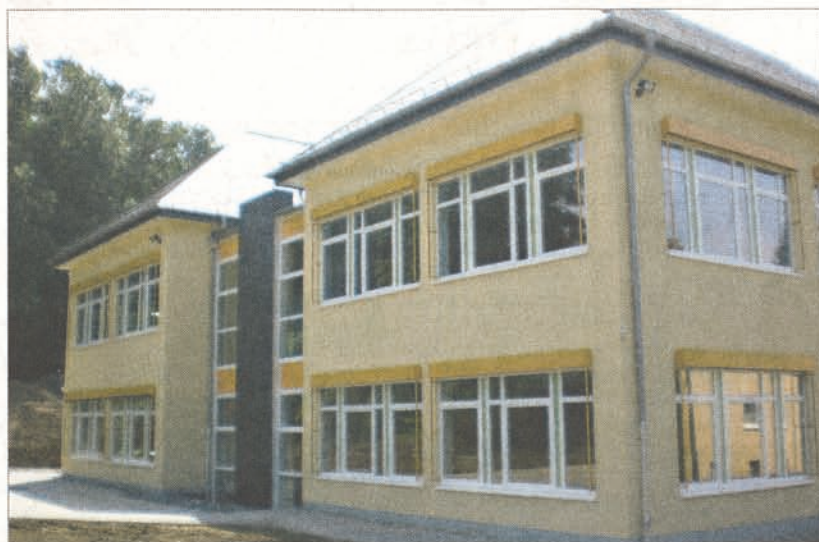
Der Neubau am Gymnasium Stift Keppel passt sich gut in das historische Gesamtbild ein. Nach rund einem Jahr Bauzeit wurde er jetzt fertiggestellt. Fotos: jw
